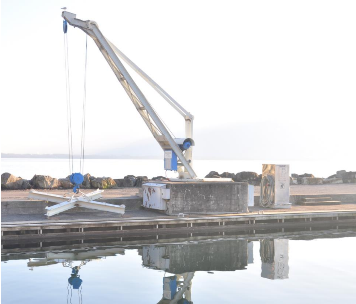
Digue Est - Grue de levage et station de pompage des eaux de cales et fécales
