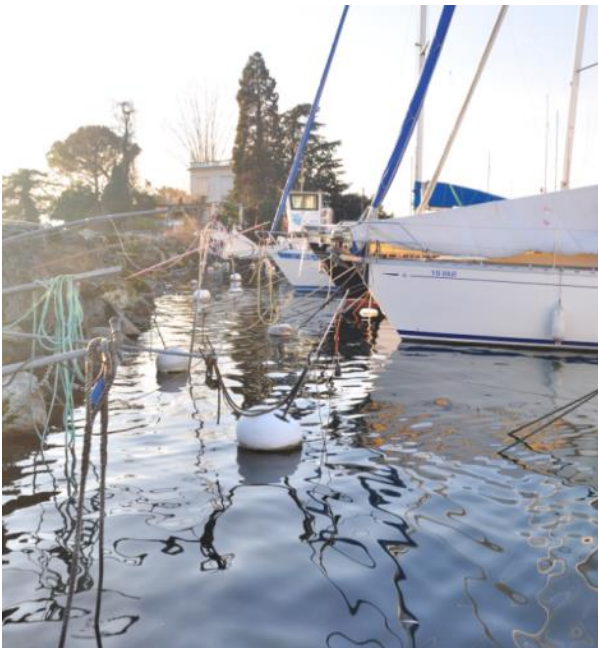
Digue de Vaudaire - Situation de l'amarrage, il n'y a pas de passerelle pour atteindre le bateau
