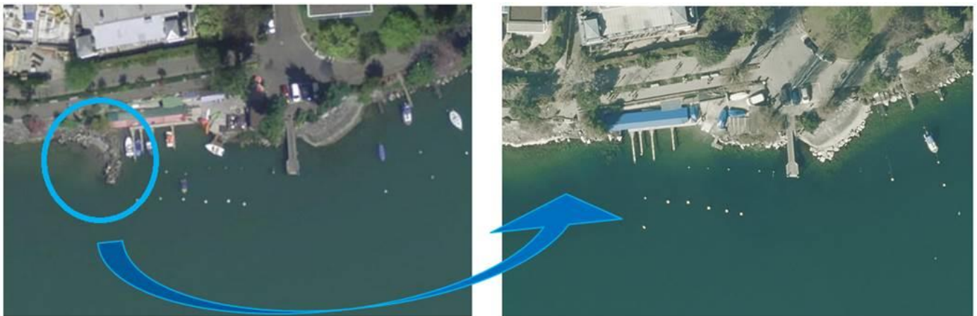
Situation 2010, avant l'effondrement de la digue
