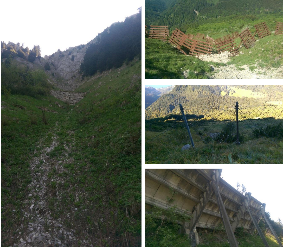
Exemples des systèmes en tête de bassin de la Baye de Montreux, construits pour favoriser le reboisement afin de pérenniser le massif forestier (mûrs en moellons et paravalanches)
