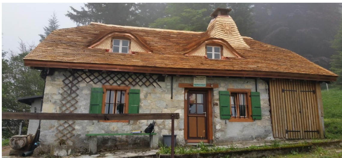
Réfection de la totalité de la toiture en tavillons (préavis No 09/2019)
