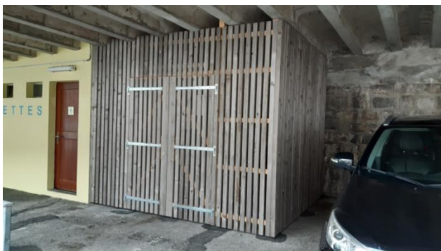
Rue du Temple 11, à Montreux Aménagement d'un abri à vélos
