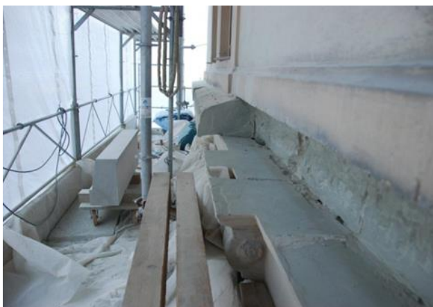
Réfection de la corniche en pierre naturelle de la façade nord et peinture
