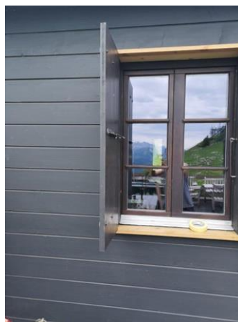
Réfection complète de la façade d'une salle à manger suite à des infiltrations d'eau
