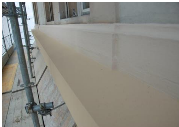
Réfection de la corniche en pierre naturelle de la façade nord et peinture
