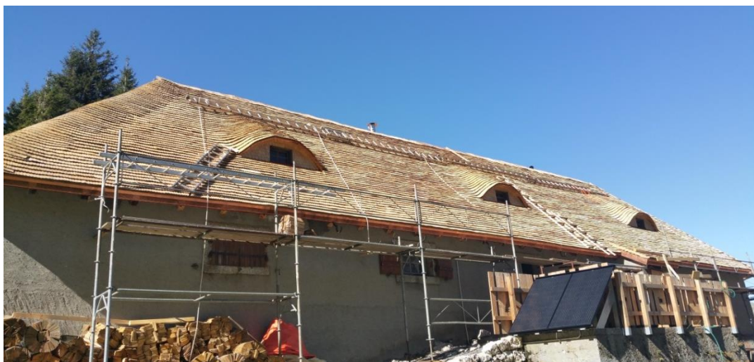
Réfection des trois quarts de la toiture en tavillons (préavis No 09/2019)
