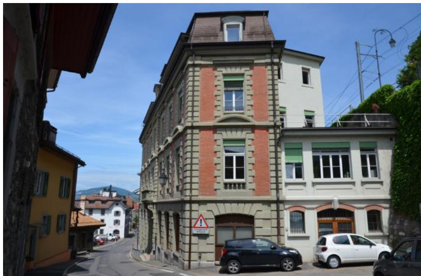
Bâtiment de la rue du Temple 11 à Montreux
