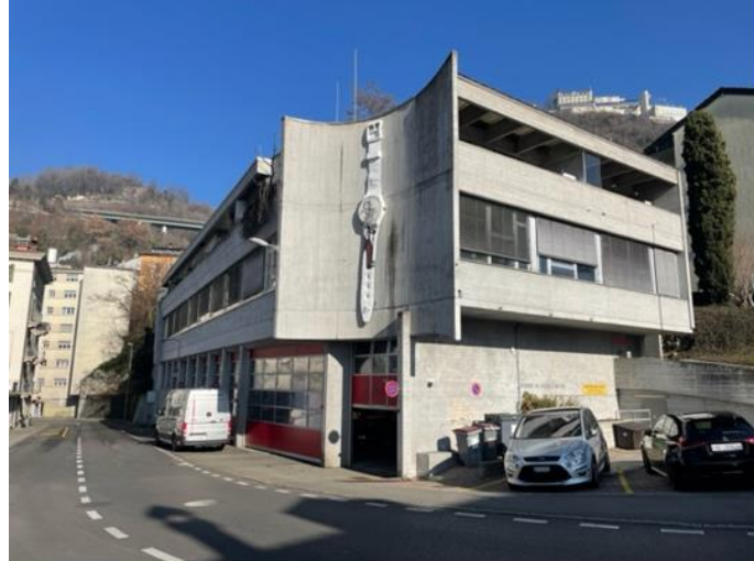
Bâtiment sis rue de la Corsaz 2-4-6 à Montreux
