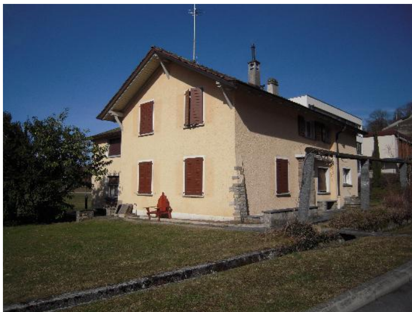
Bâtiment locatif du chemin de Muraz 15
