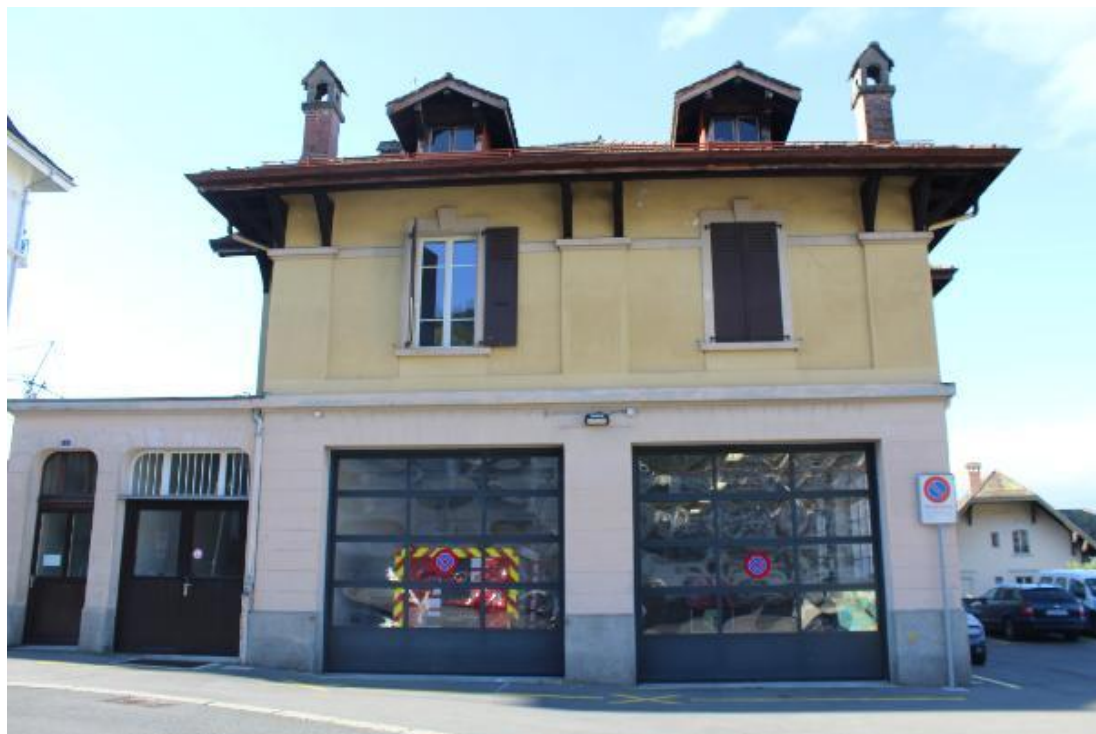
Bâtiment de la rue de la Corsaz 1
